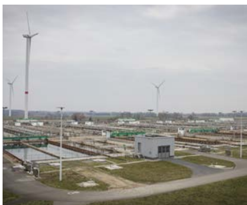
Blick über das Klärwerk auf die Windräder © ahnenenkel.com/Silke Reents
