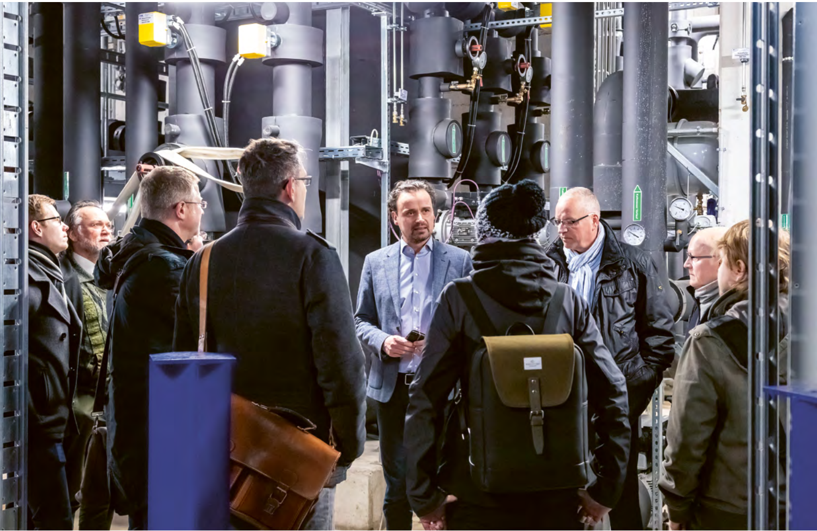
▲ Besichtigung des Vakuumeis-Kältespeichers in Göttingen.
