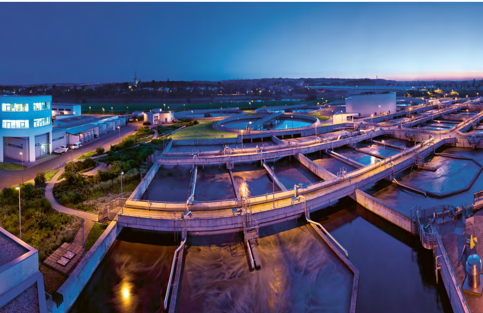
▲ Kläranlage in Dresden.
