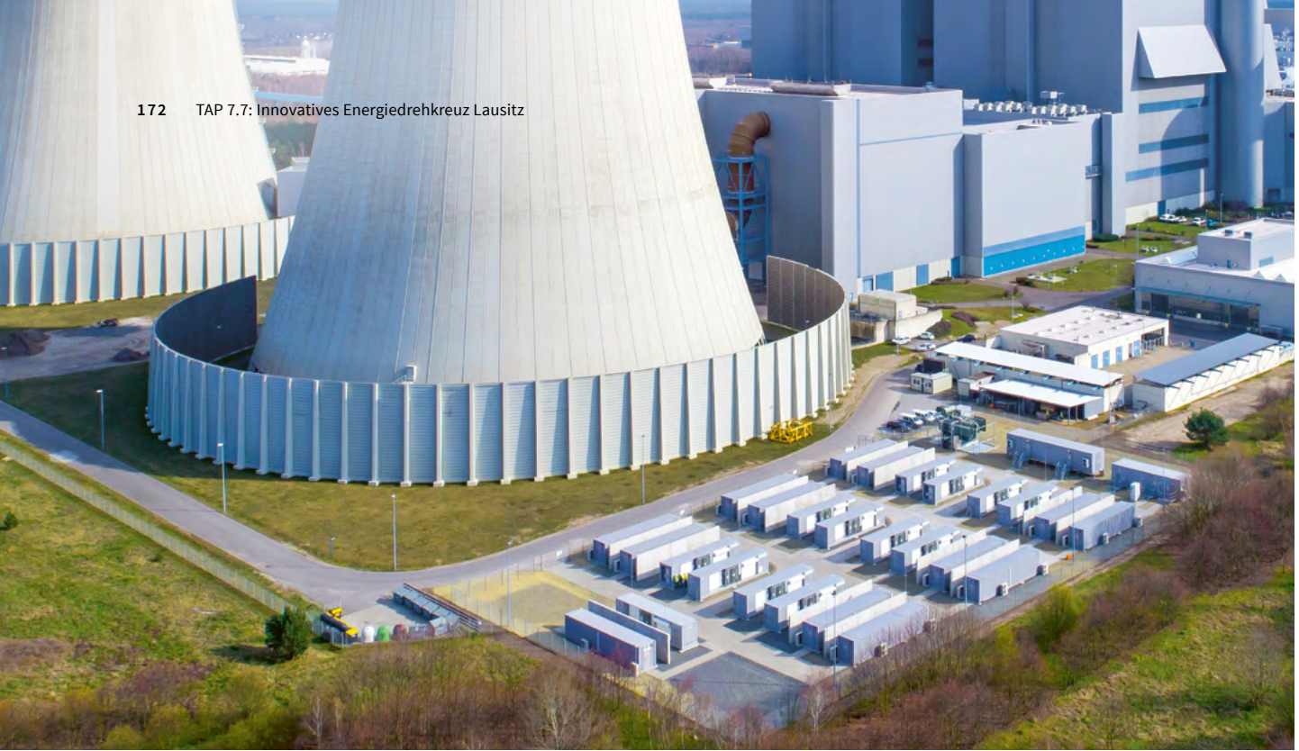
▲ Großbatterie am Kraftwerk Schwarze Pumpe.
