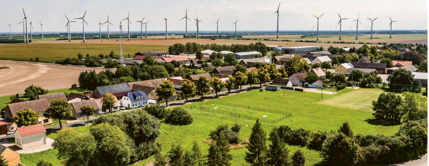
▲ Wind- und Solaranlage in Feldheim.
