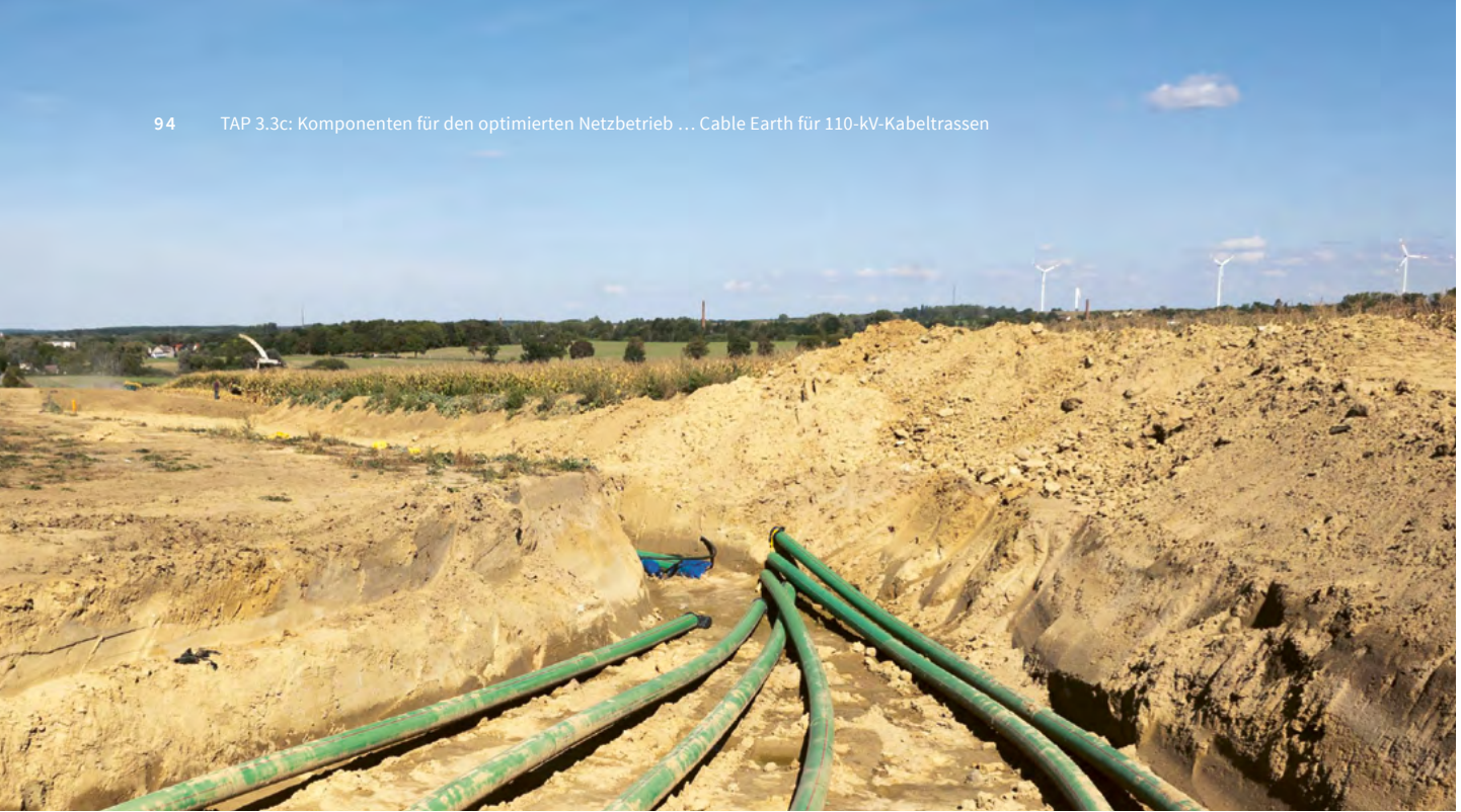
▲ Bau der 110-kV-Kabeltrasse Oderland der E.DIS Netz GmbH.
