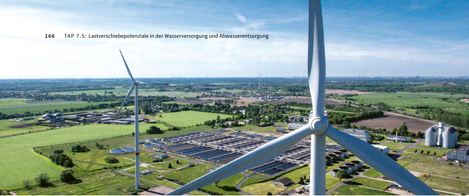
▲ Luftaufnahme des Klärwerks Schönerlinde der Berliner Wasserbetriebe.
