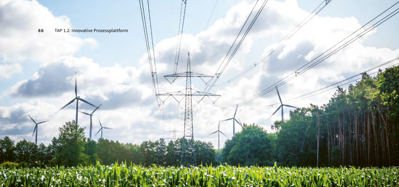
▲ Höchstspannungsleitungen mit Windkraftanlagen in der 50Hertz-Regelzone.
