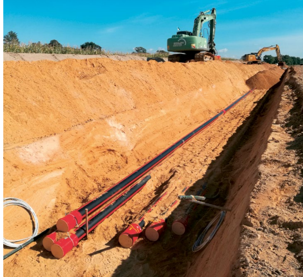
► Bau einer erdverlegten Kabeltrasse.
