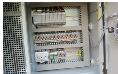
► Komponenten im Messschrank: Messsystem und abgesetzte Bedieneinheit in der Schranktür.
