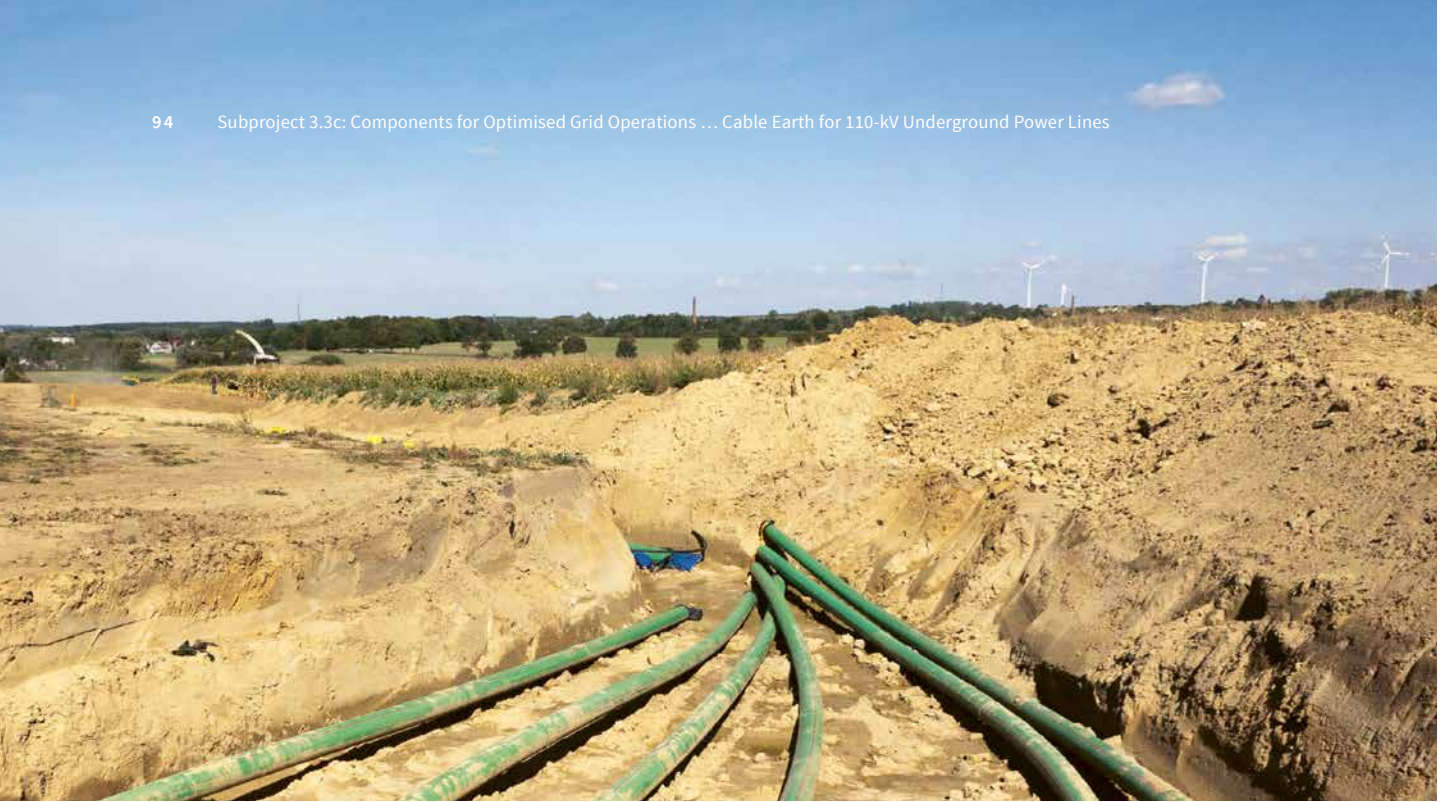
▲ Laying of E.DIS Netz GmbH's 110-kV Oderland cable
